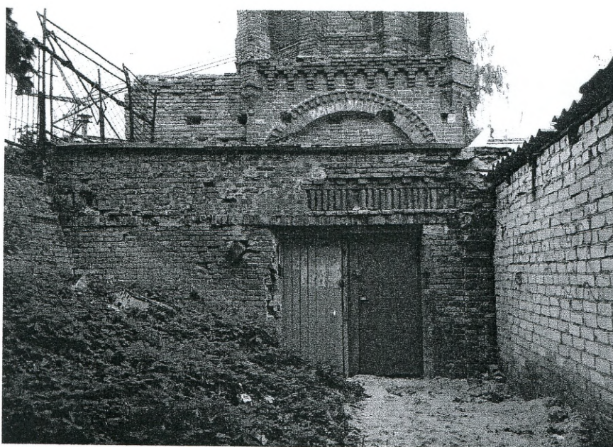
4. «Водонапорная башня. 1874 г.», г. Курск, ул. Павлова Элемент фасада. Материалы фотофиксации подготовил главный специалист ОБУК «Инспекция по охране объектов культурного наследия» Большакова Ю.А. Октябрь 2015 г.
